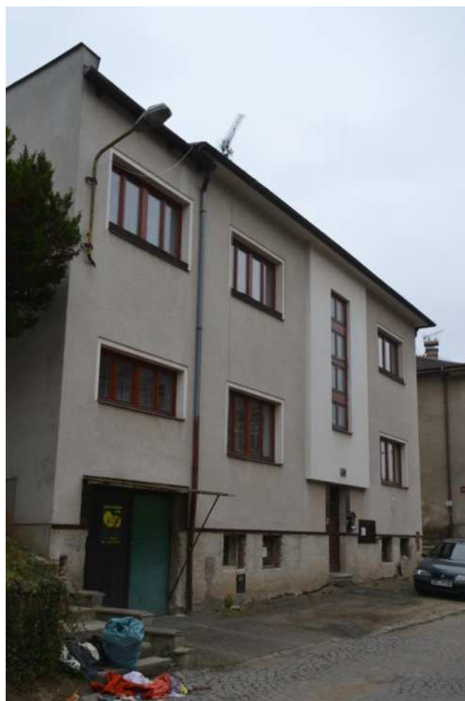
Dům č. p. 105, hlavní západní průčelí, foto IP 2014.
