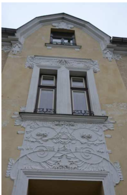
Dům č. p. 103, hlavní západní průčelí, detail rizalitu nad vstupem, foto IP 2014.
