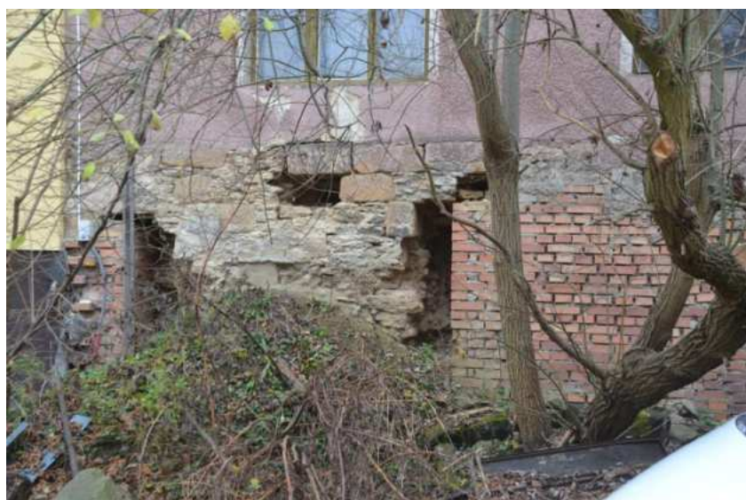
Dům č. p. 404, západní průčelí, detail struktury zdiva v úrovni soklu, foto IP 2014.
