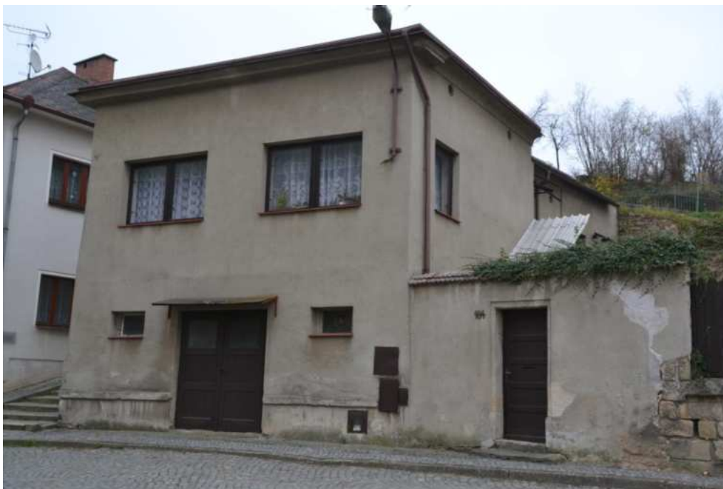
Dům č. p. 104, hlavní západní průčelí, foto IP 2014.
