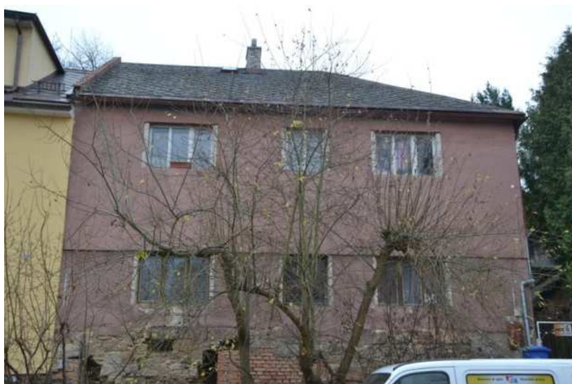
Dům č. p. 404, západní průčelí, foto IP 2014.
