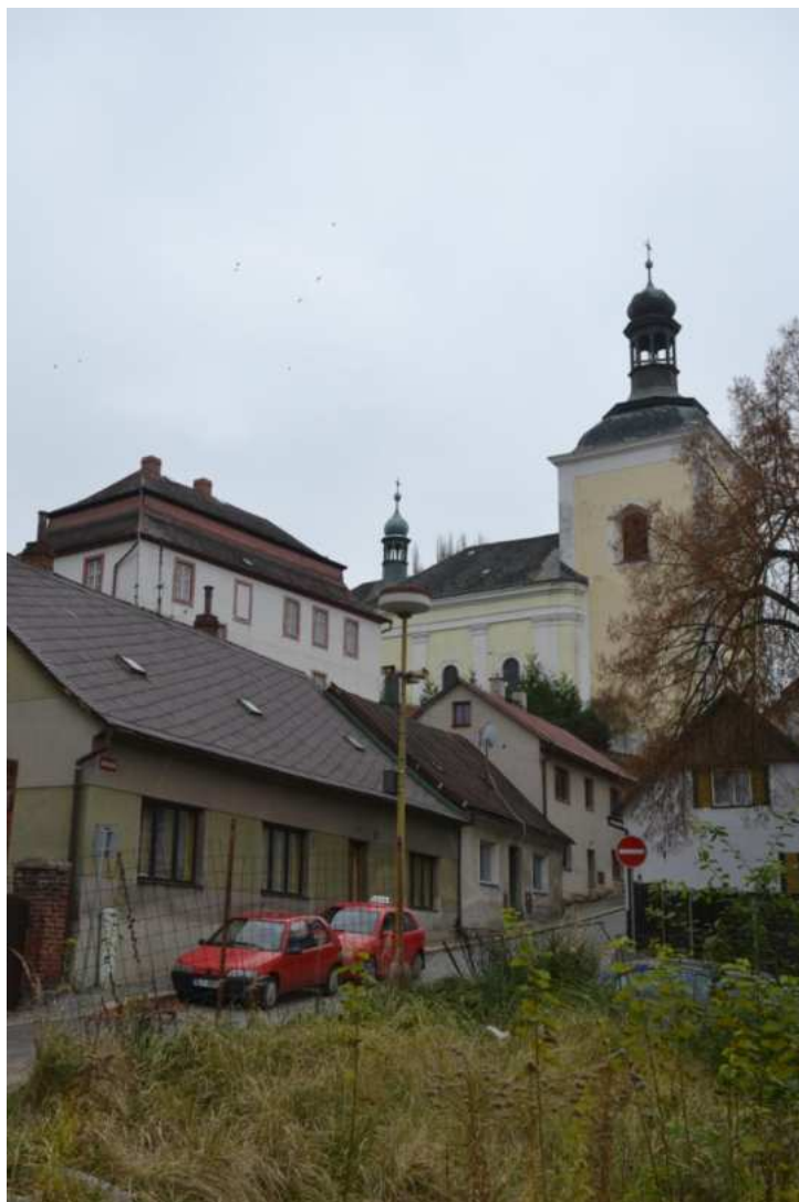
Dům č. p. 101, hlavní západní průčelí, foto IP 2014.
