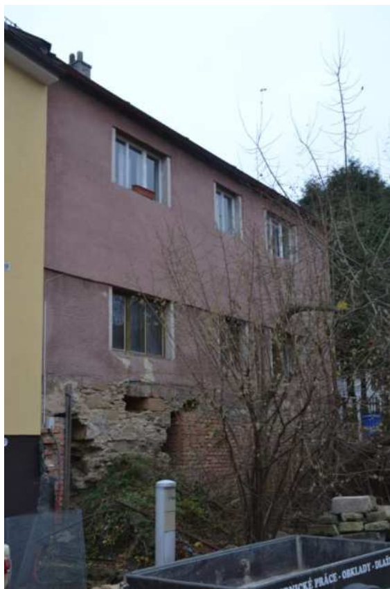
Dům č. p. 404, západní průčelí, foto IP 2014.
