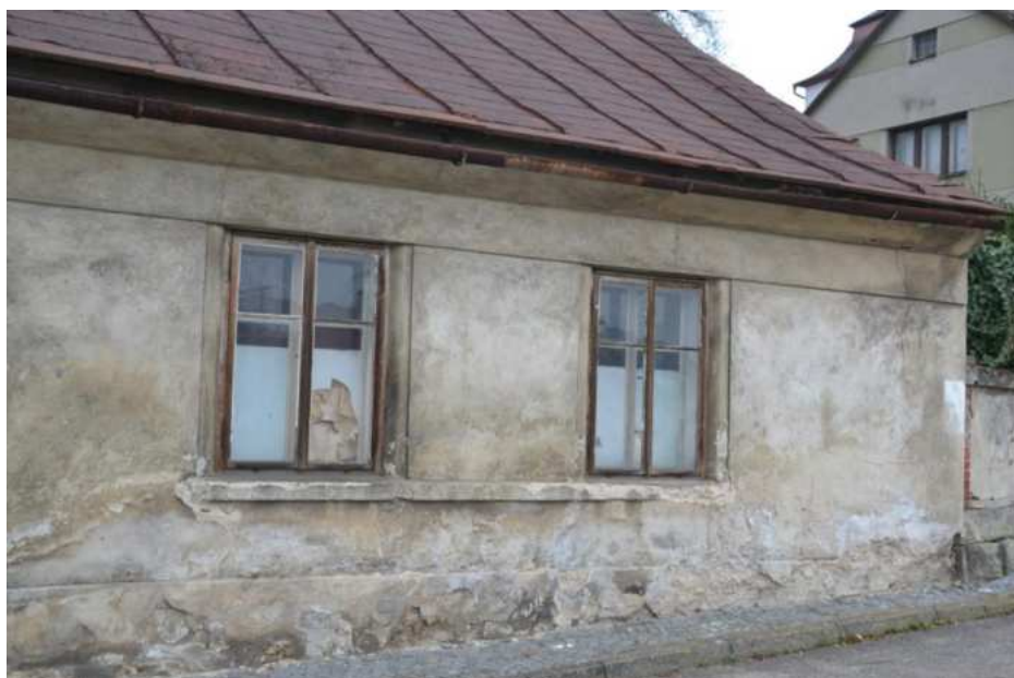
Dům č. p. 102, detail oken u západního průčelí – jižní část, foto IP 2014.
