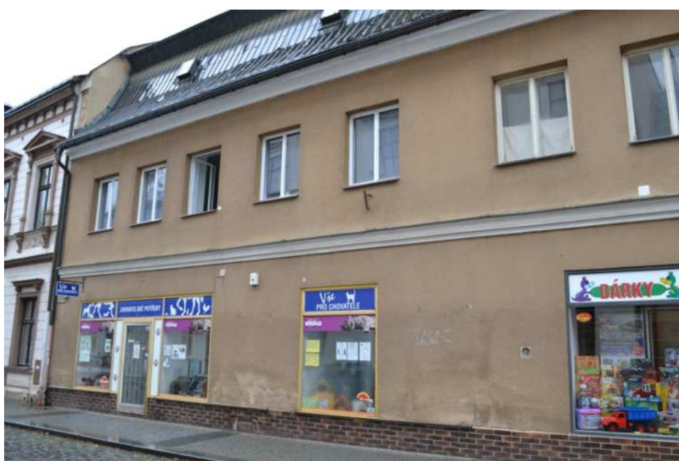
Dům č. p. 82, hlavní východní průčelí – jižní část, foto MK 2013.
