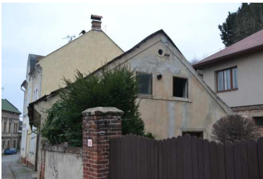
Dům č. p. 102, detail jižního štítového průčelí, foto IP 2014.
