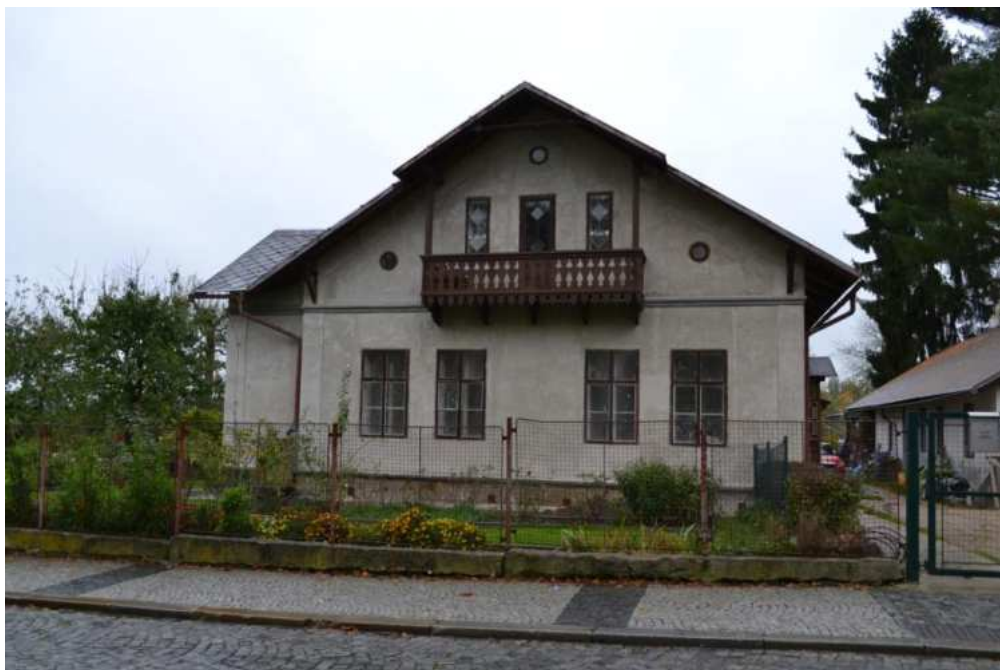
Dům č. p. 465, východní štítové průčelí, foto MK 2014.
