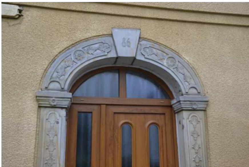
Dům č. p. 86, detail záklenku vstupního portálu, foto IP 2014.
