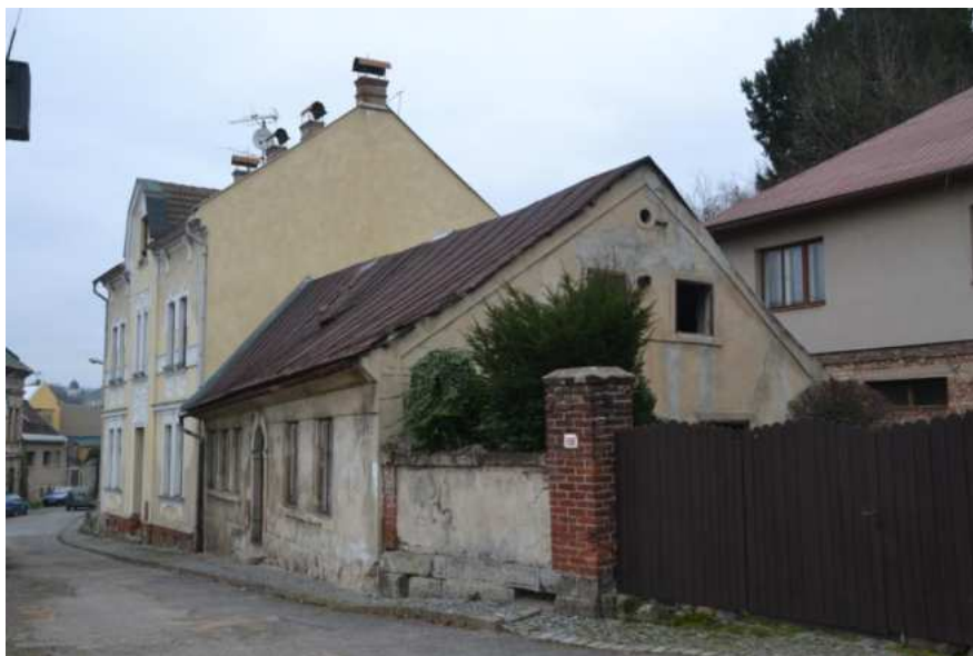
Dům č. p. 102, celkový pohled na jižní štítové a západní vstupní průčelí, foto IP 2014.
