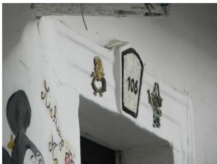
Dům č. p. 106, detail nadpraží vstupu u jižního průčelí, foto MK 2014.
