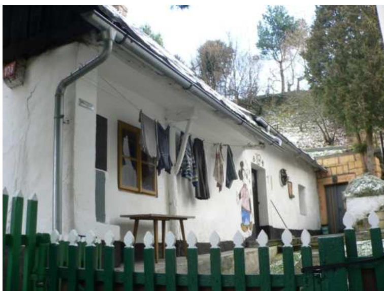
Dům č. p. 106, jižní průčelí, foto MK 2014.
