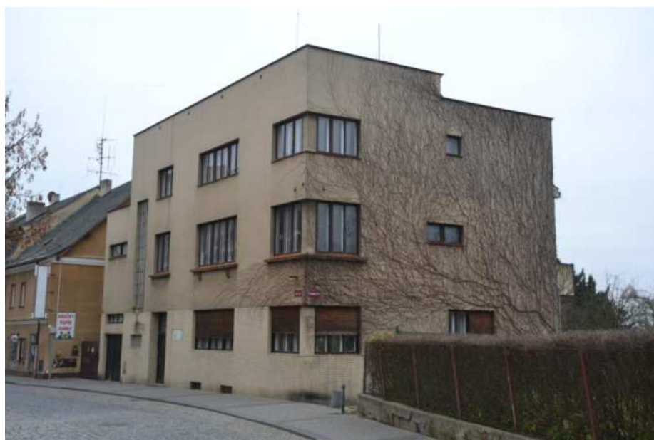
Dům č. p. 917, celkový pohled od severovýchodu, foto IP 2014.
