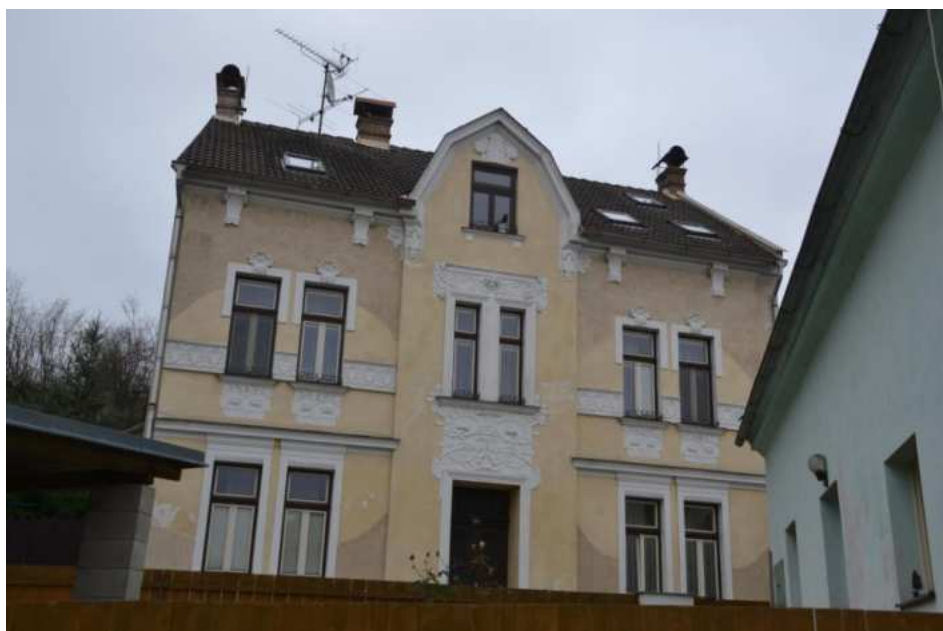
Dům č. p. 103, hlavní západní průčelí, foto IP 2014.
