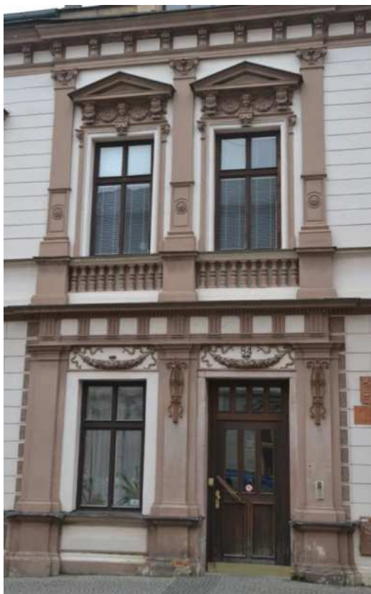
Dům č. p. 84, detail vstupní části hlavního průčelí, foto IP 2014.
