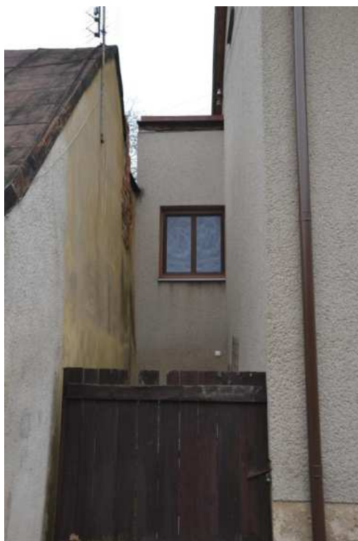
Dům č. p. 99, proluka u severního štítového průčelí, foto IP 2014.
