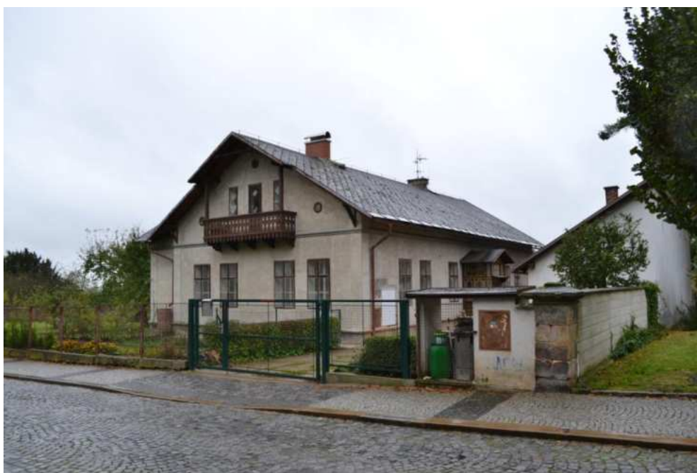
Dům č. p. 465, celkový pohled od severovýchodu, foto MK 2014.
