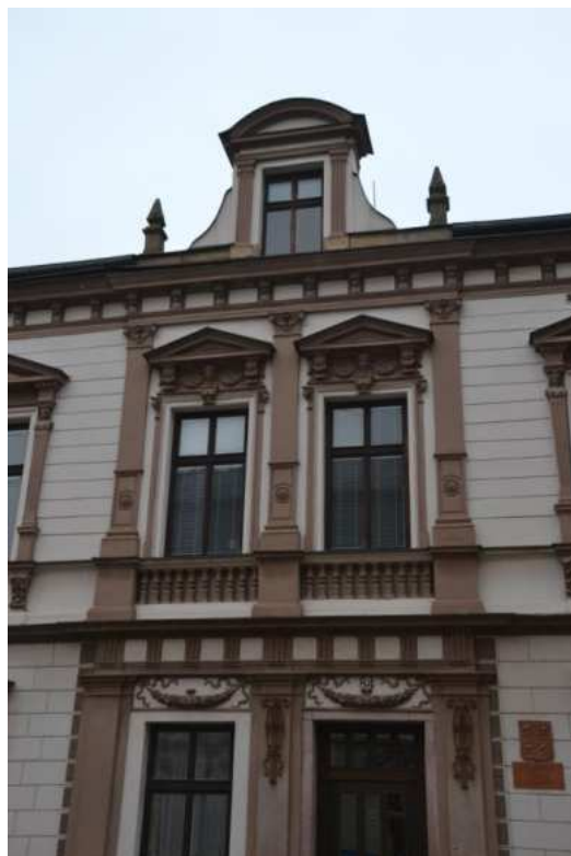
Dům č. p. 84, detail hlavního průčelí nad vstupem, foto IP 2014.
