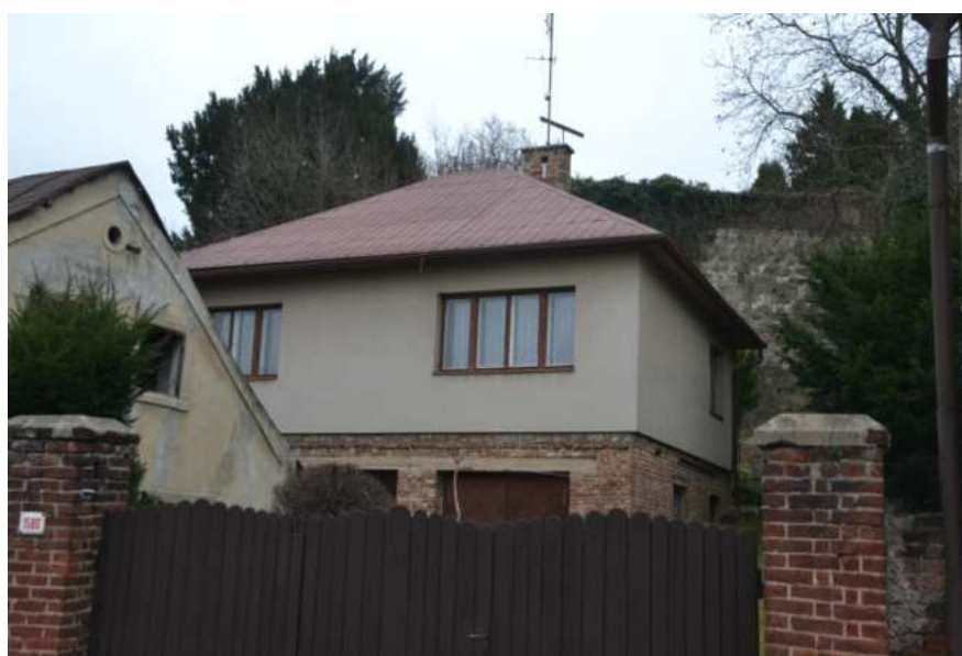
Dům č. p. 1580, západní a jižní průčelí, foto IP 2014.
