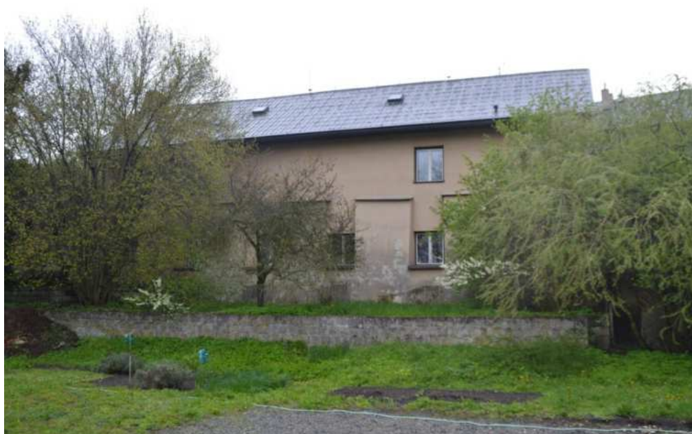
Dům č. p. 83 – pohled od západu, foto IP 2016.
