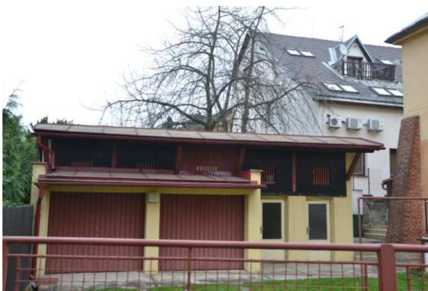
Dům č. p. 86, stavba dvojgaráže, foto IP 2014.
