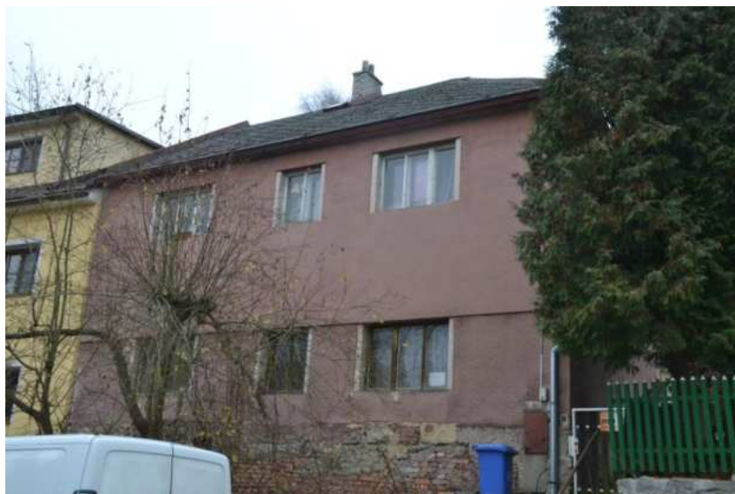
Dům č. p. 404, západní průčelí, foto IP 2014.
