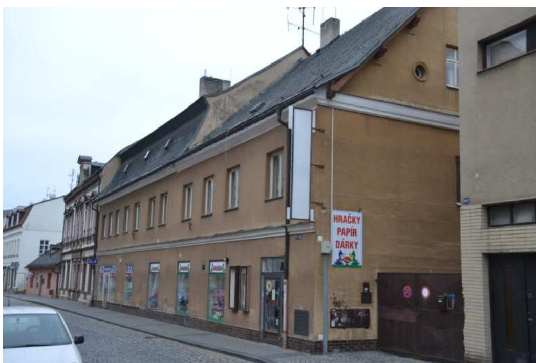
Dům č. p. 82, hlavní východní průčelí a štítové severní průčelí, foto IP 2014.
