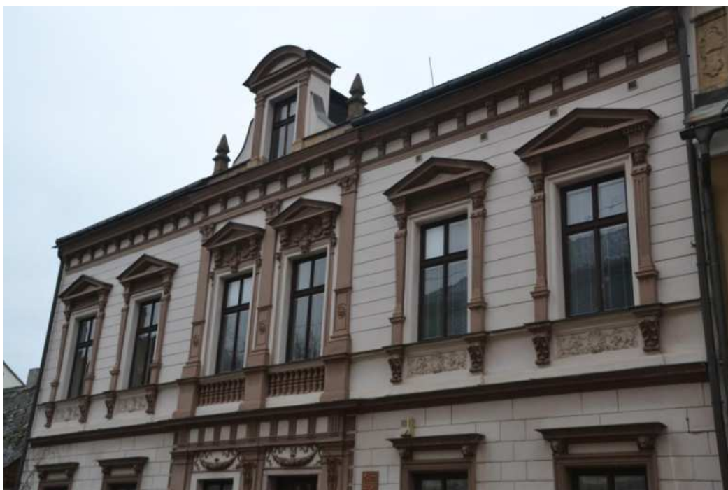
Dům č. p. 84, detail patra hlavního východního průčelí, foto IP 2014.
