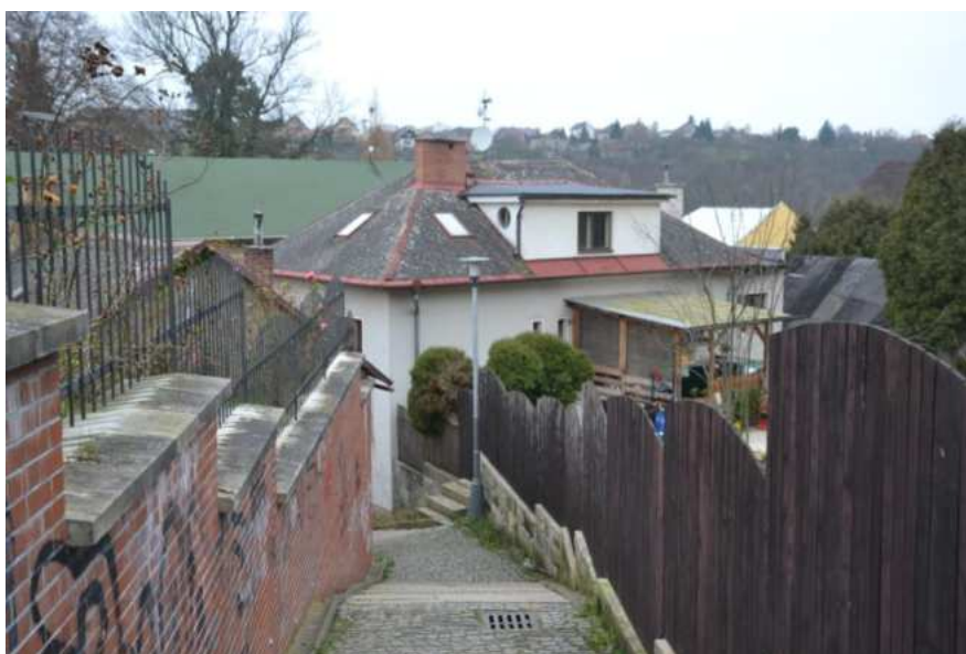
Dům č. p. 105, střecha a zadní východní průčelí, foto IP 2014.
