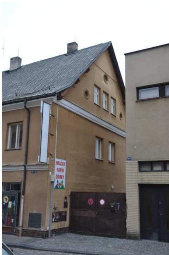
Dům č. p. 82, štítové severní průčelí, foto IP 2014.
