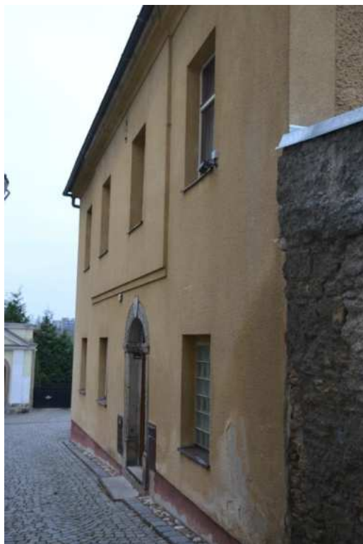
Dům č. p. 86, hlavní jižní průčelí domu, foto IP 2014.
