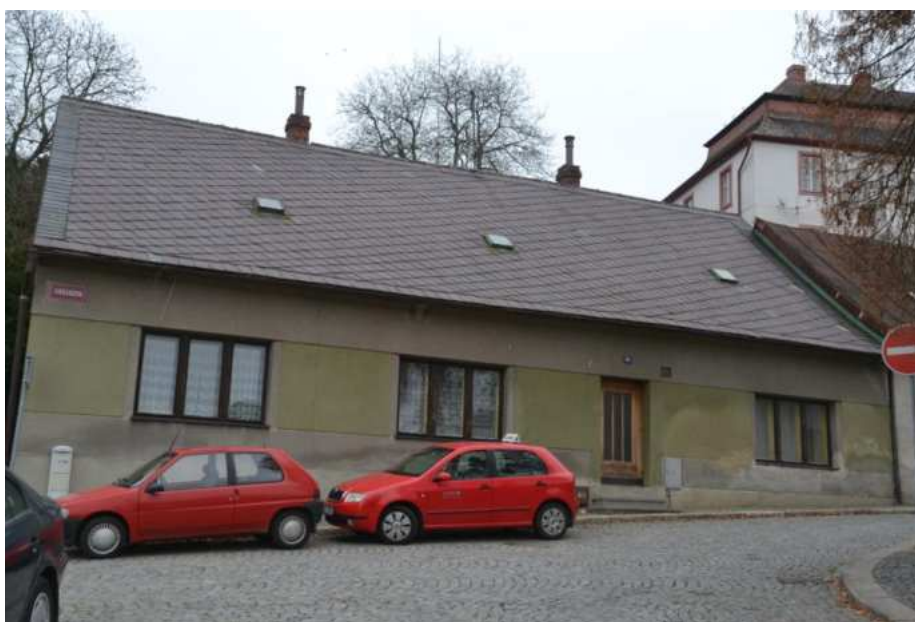
Dům č. p. 101, hlavní západní průčelí, foto IP 2014.
