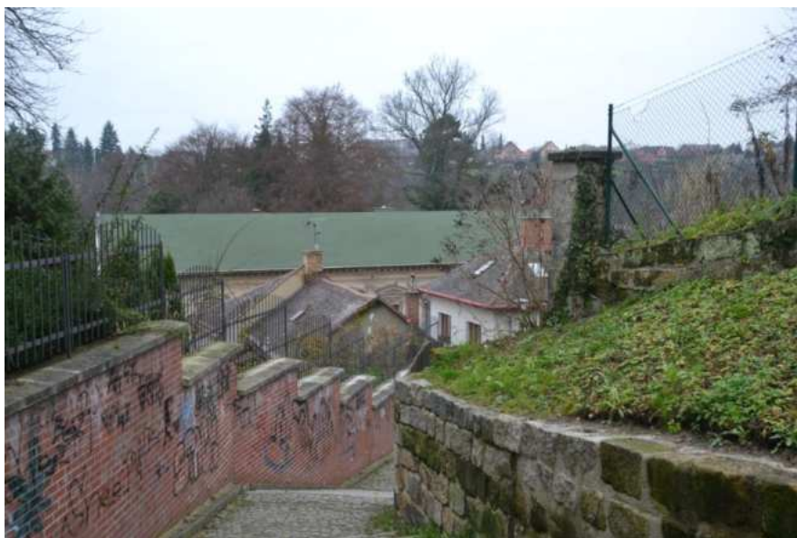
Dům č. p. 104, střecha a zadní křídlo, foto IP 2014.
