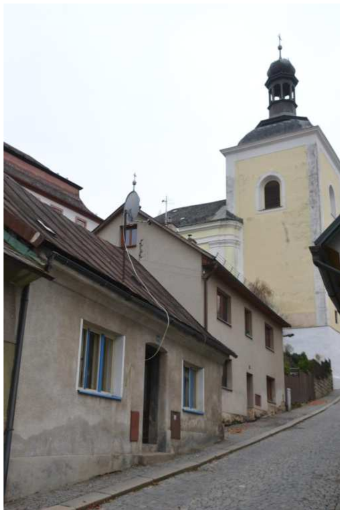
Dům č. p. 99 (druhý zleva) severní štítové a hlavní západní průčelí, foto IP 2014.
