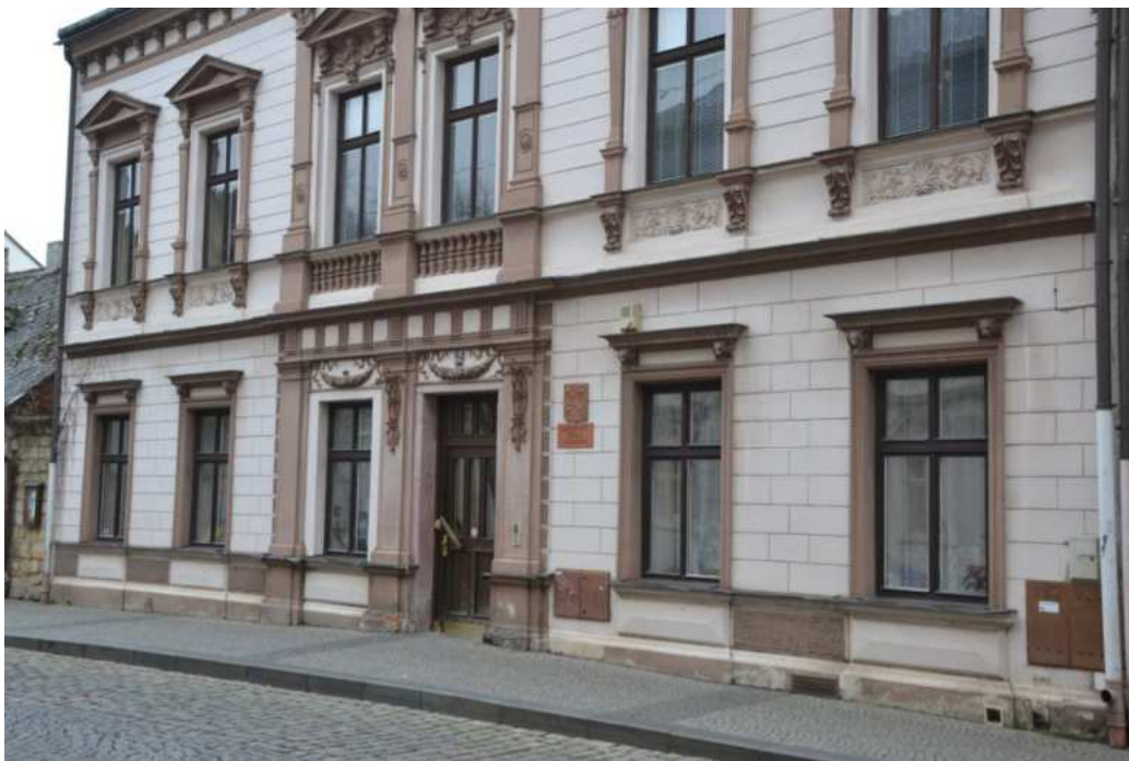
Dům č. p. 84, detail přízemí hlavního východního průčelí, foto IP 2014.
