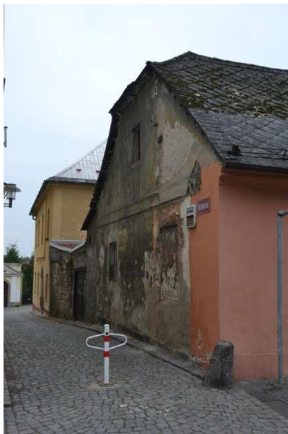
Dům č. p. 85, boční jižní průčelí domu, foto IP 2014.
