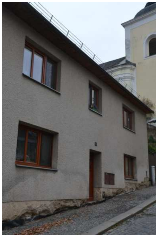
Dům č. p. 99, detail hlavního západního průčelí, foto IP 2014.
