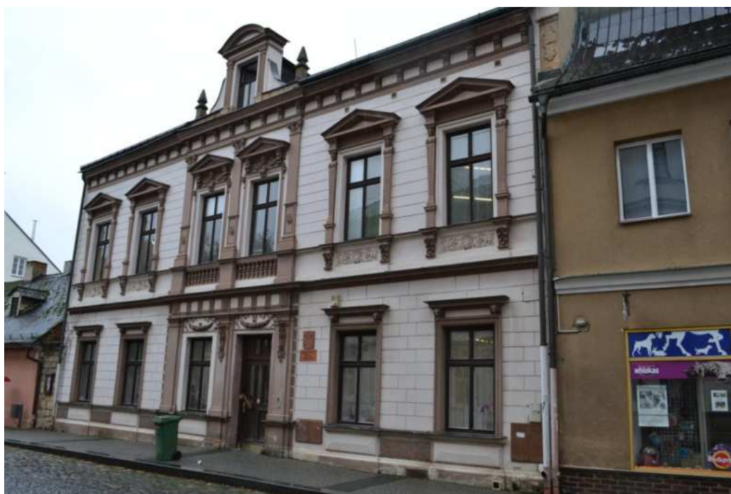
Dům č. p. 84, celkový pohled na hlavní východní průčelí, foto MK 2014
