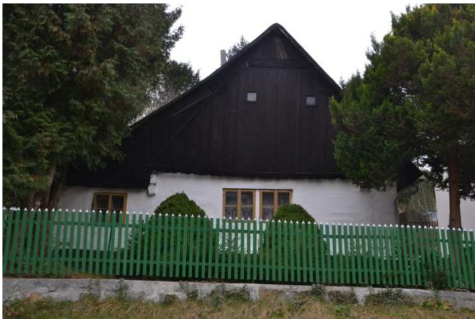
Dům č. p. 106, západní štítové průčelí, foto IP 2014.
