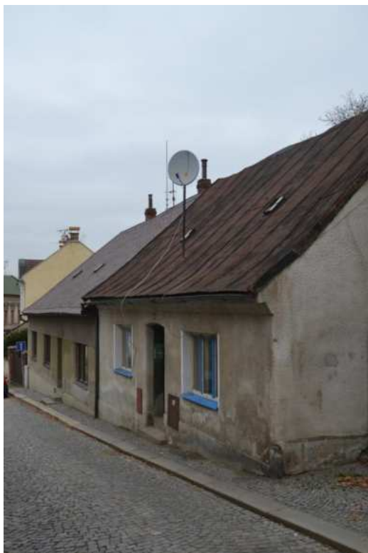
Dům č. p. 100, hlavní západní průčelí, foto IP 2014.
