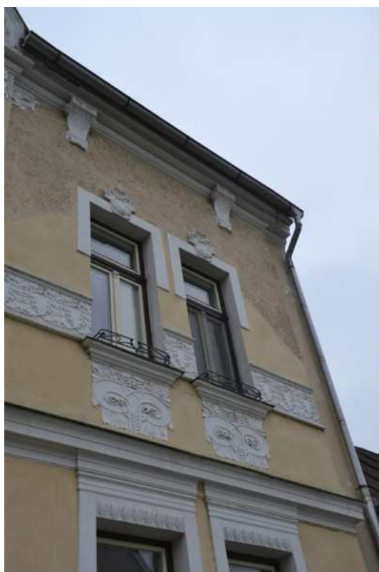
Dům č. p. 103, hlavní západní průčelí, detail oken v patře, foto IP 2014.
