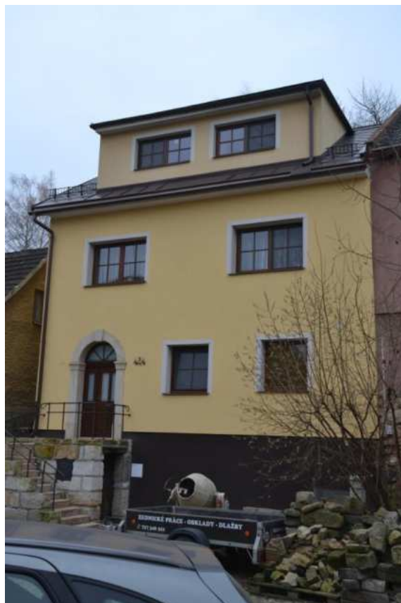
Dům č. p. 424, hlavní západní průčelí, foto IP 2014.
