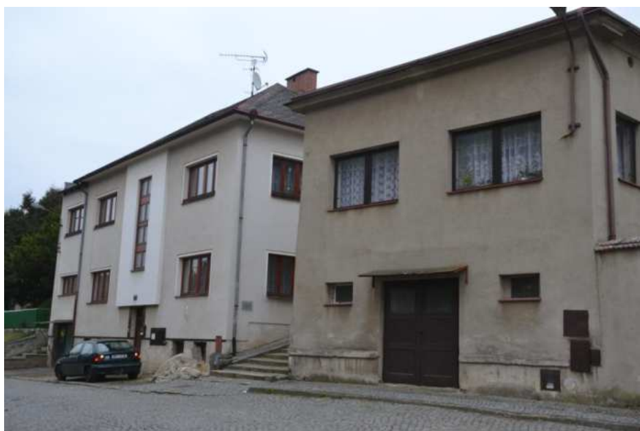
Dům č. p. 105, pohled na hlavní západní průčelí, foto IP 2014.
