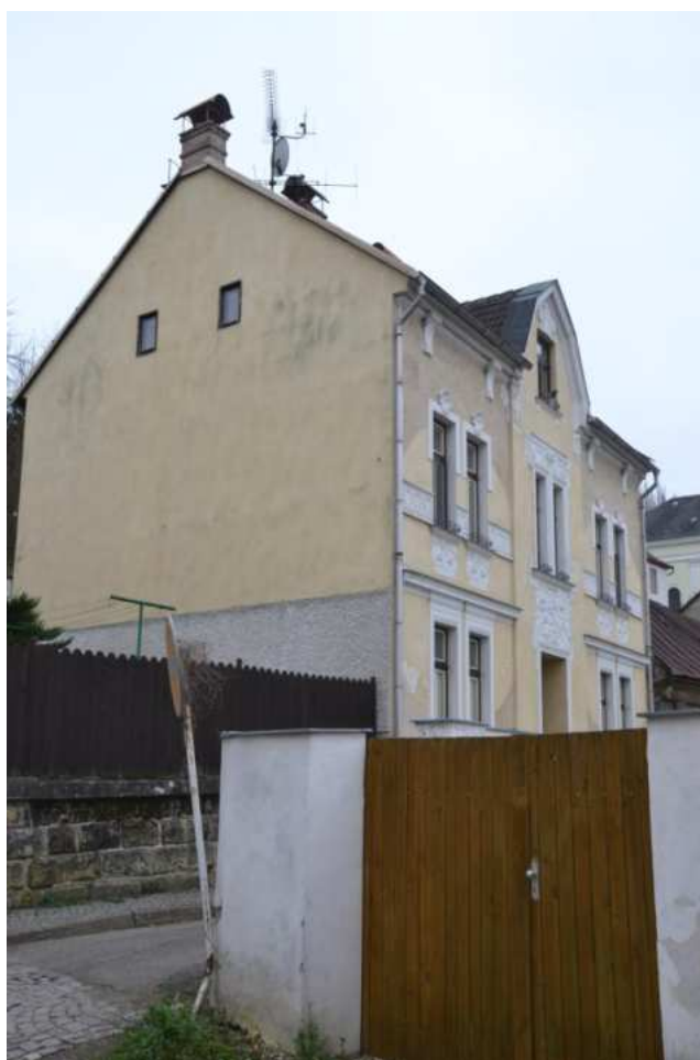
Dům č. p. 103, hlavní západní a severní štítové průčelí, foto IP 2014.
