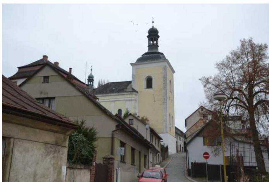
Dům č. p. 101, severní štítové a hlavní západní průčelí, foto IP 2014.
