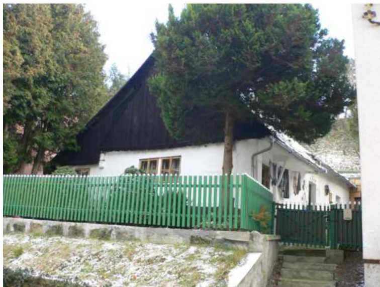
Dům č. p. 106, celkový pohled od jihozápadu, foto MK 2014.
